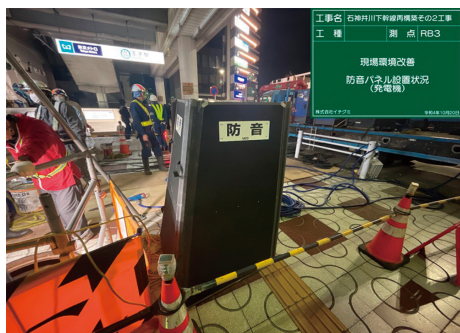
〈発電機（防音パネル設置状況）〉
