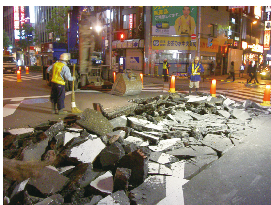
〈開削工事の建設廃棄物〉
