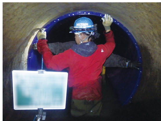
〈施工している様子〉
