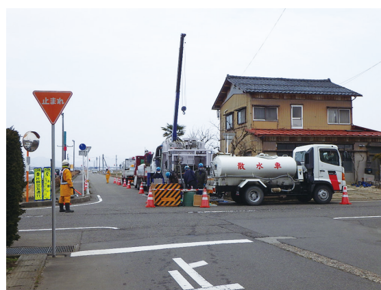
〈管路更生工事の現場風景〉
