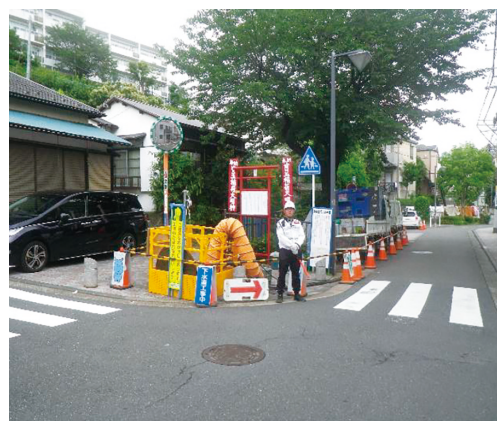
〈管路更生工事の交通規制〉
