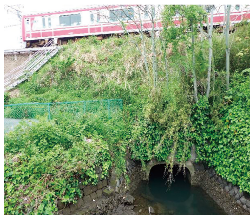
〈軌道下の管路更生工事〉
