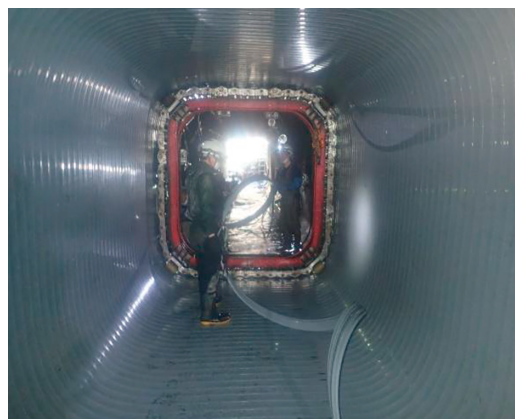
〈施工している様子〉
