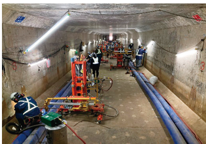
空港関係工事の 様子
