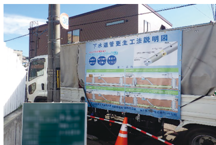
遮音シートによる防音対策
