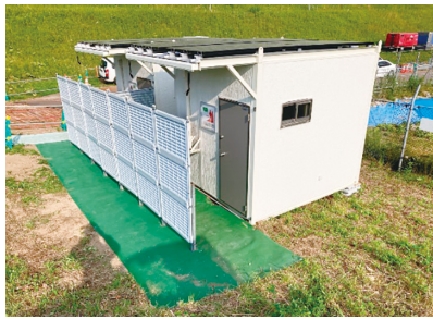
ソーラー・トイレの 設置
