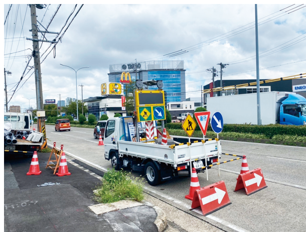
〈施工現場の様子〉
