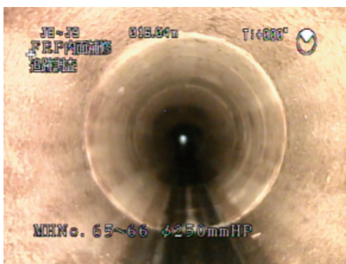
TVカメラ調査（経年14年）光硬化
