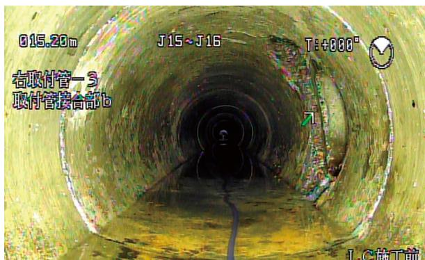
写真8 取付管口閉塞 施工前（直視）
