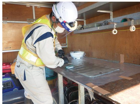
写真3 ライニング材への含浸作業
