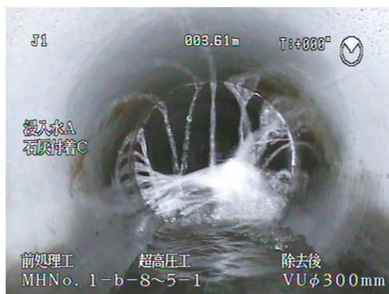
写真2 高圧洗浄による支障物除去
