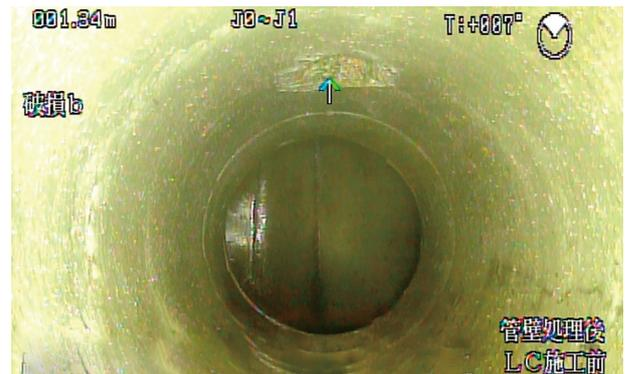
写真2 破損部の補修 施工前（直視）
