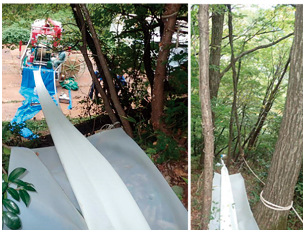
写真4 到達側ベルト引き取り状況
