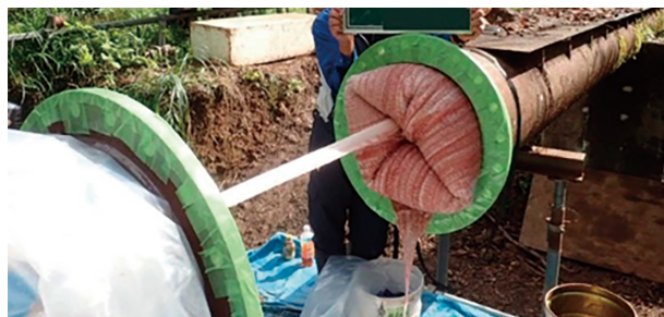
写真5 反転状況（排泥管撤去部）
