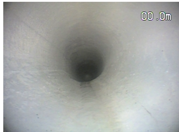
写真5 更生完了状況
