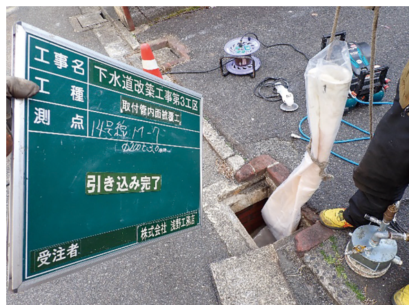
写真2 ライナー材引き込み完了
