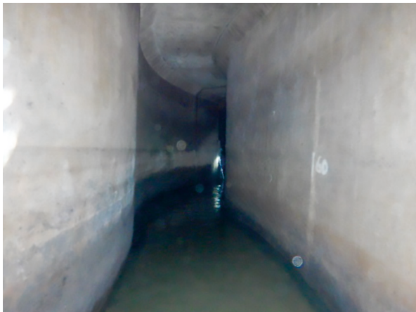
写真3 施工前の管内
