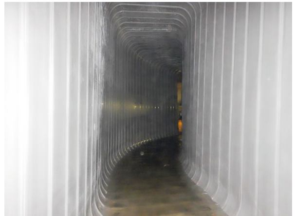
写真6 施工後の管内
