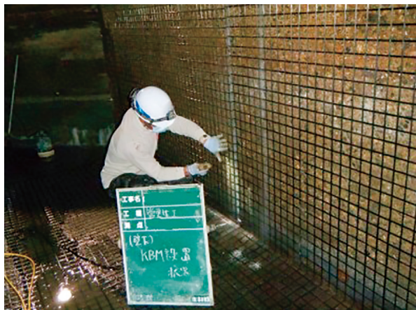
写真9 補強材設置
