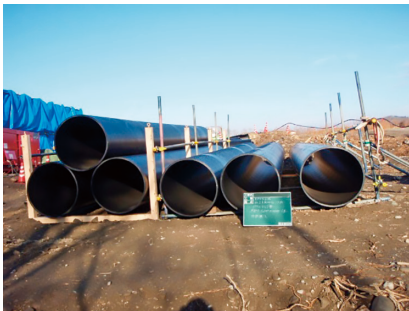
写真3 ポリエチレン管搬入 L=10m
