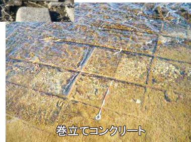
写真1 巻立てコンクリートの鉄筋露出状況
