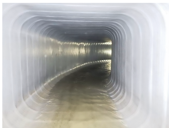
写真2 施工後の管内
