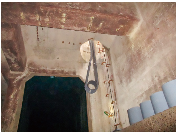
写真4 ライニング材の管内搬入状況
