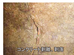
写真1 巻立てコンクリートの鉄筋露出状況
