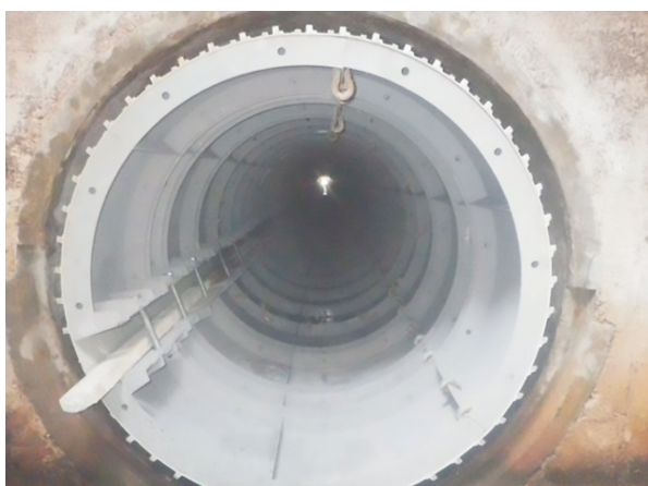
写真5 表面部材および型枠設置
