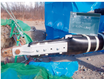
写真6 トーイングヘッド取付け
