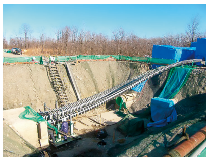
写真7 サブライン管引込み挿入
