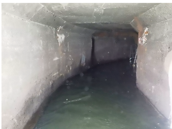
写真1 施工前の管内
