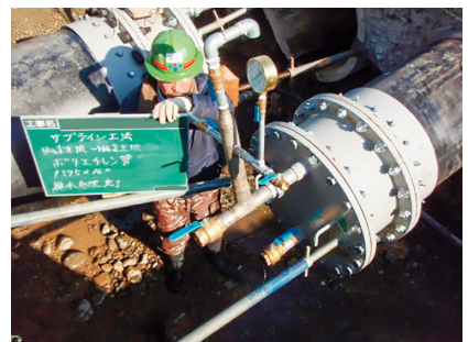
写真8 水圧復元、耐圧試験
