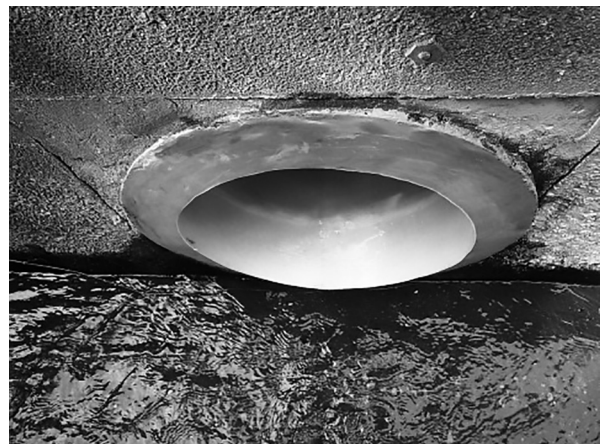
写真2 φ400mm管口仕上げ後
