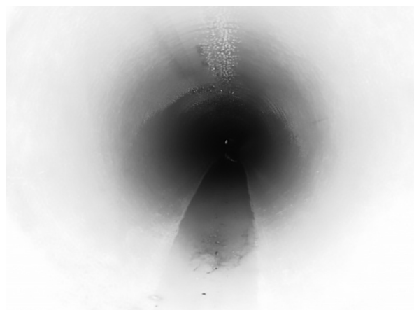
写真8 施工後管内写真
