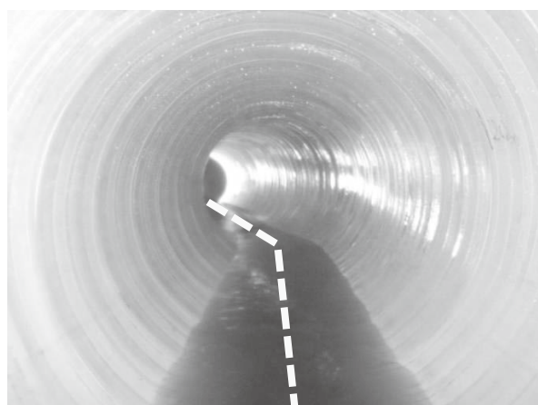
写真8 12°屈曲管きょへの対応（施工後）
