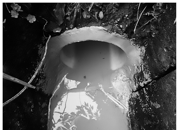
写真3 φ250mm管口仕上げ後
