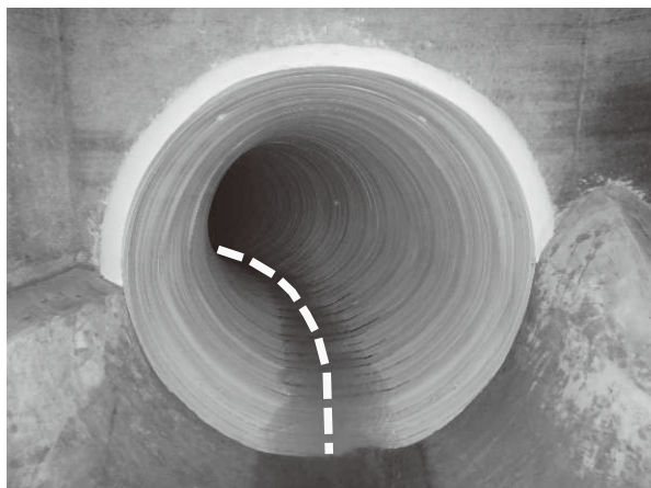
写真6 6.5mR曲線管きょへの対応（施工後）
