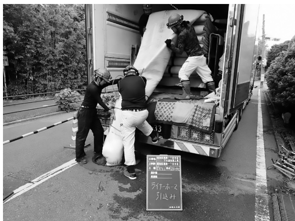
写真6 材料引込み状況
