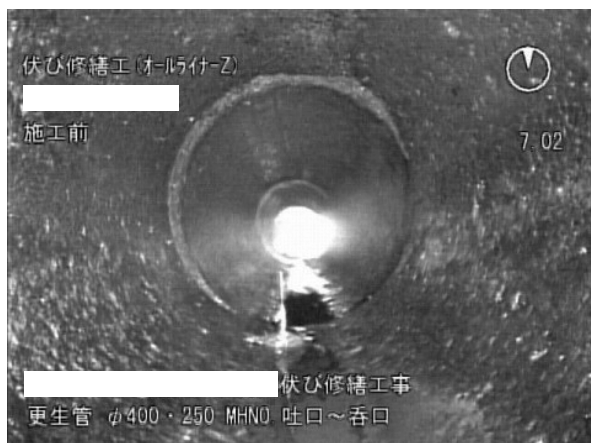
写真1 施工前管内状況
