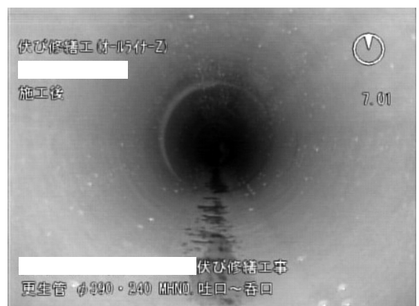
写真4 施工後管内状況
