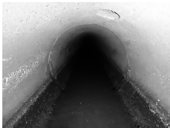
写真5 施工前管内状況
