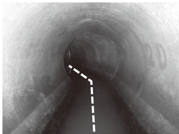
写真7 12°屈曲管きょへの対応（施工前）
