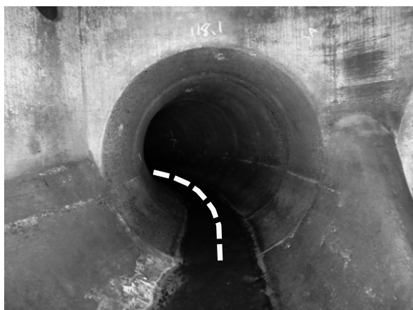
写真5 6.5mR曲線管きょへの対応（施工前）
