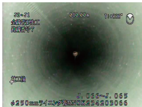
参考 管路更生工事のようす（左：施工前、右：施工後）
