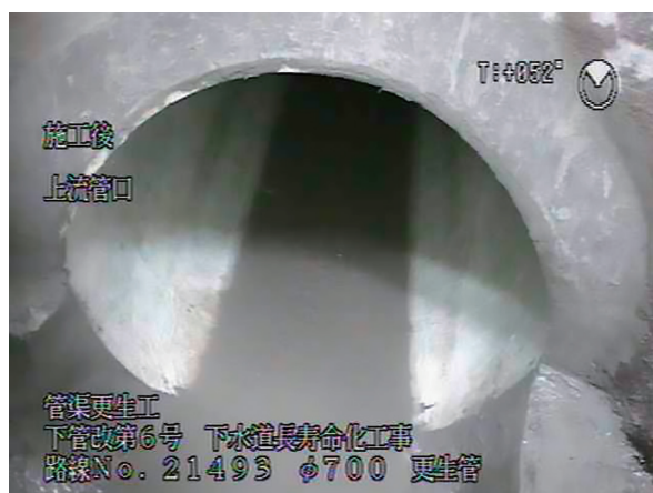
参考 管路更生工事の施工状況 施工前（上）と施工後
