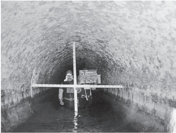
南部幹線の状況
