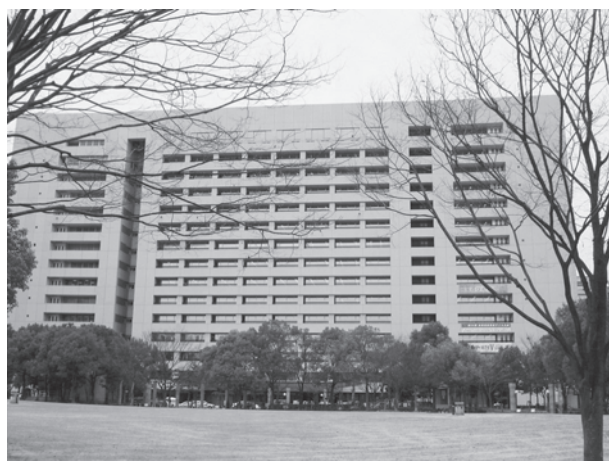
福岡市役所庁舎
