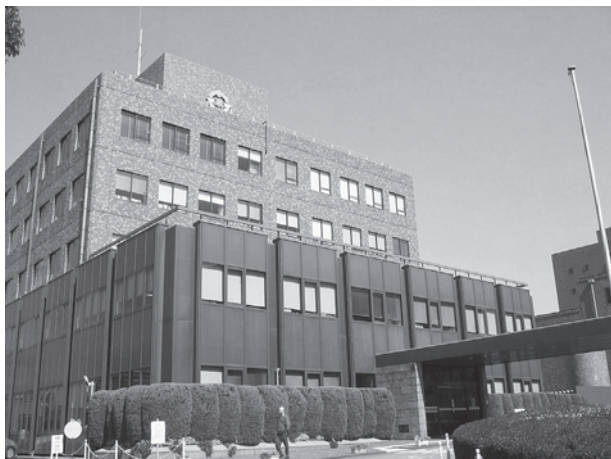
鹿児島市水道局庁舎
