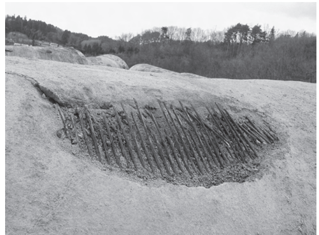
写真2 老朽管表面の劣化と PC 鋼線の破断
