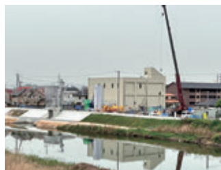
写真1 今保ポンプ場 (自家発電機棟築造中)
