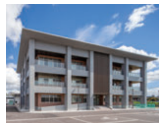
写真2 旭西排水センター管理棟
