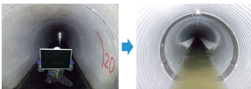
左：施工前、右：施工後
