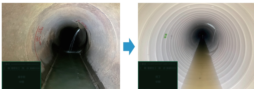
左：施工前、右：施工後
