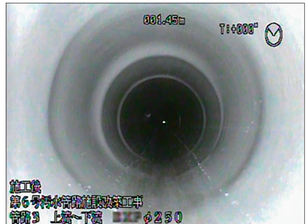
写真2：管更生工（污水）施工後
