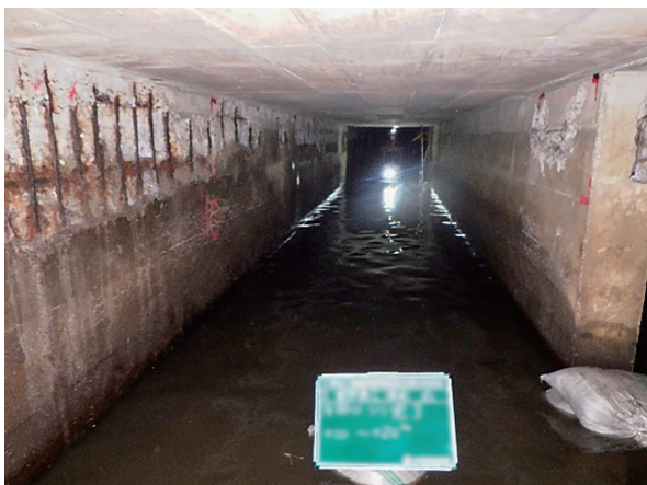
写真3：管更生工（雨水）施工前
