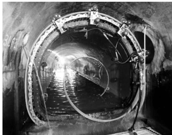
更生工法による幹線再構築（谷田川幹線）
