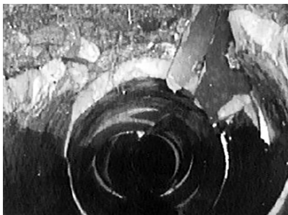
(参考) 管路更生工事の状況 施工前
