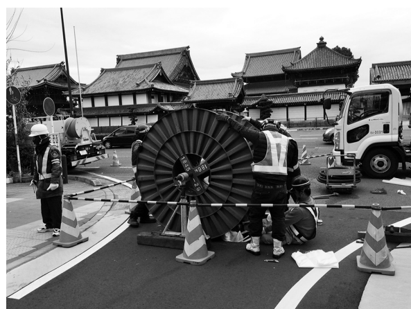
(参考) 管路更生工事の施工状況
