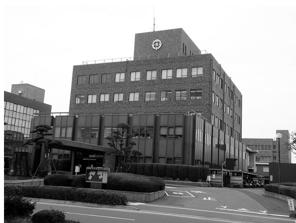
鹿児島市水道局庁舎
