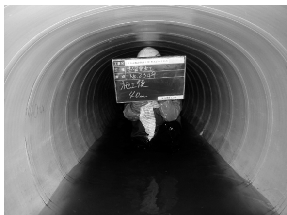
管更生後の状況（施工後）
