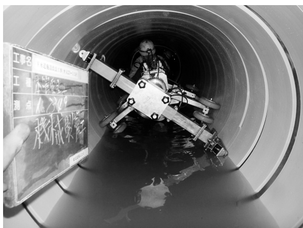
管更生状況（管内）
