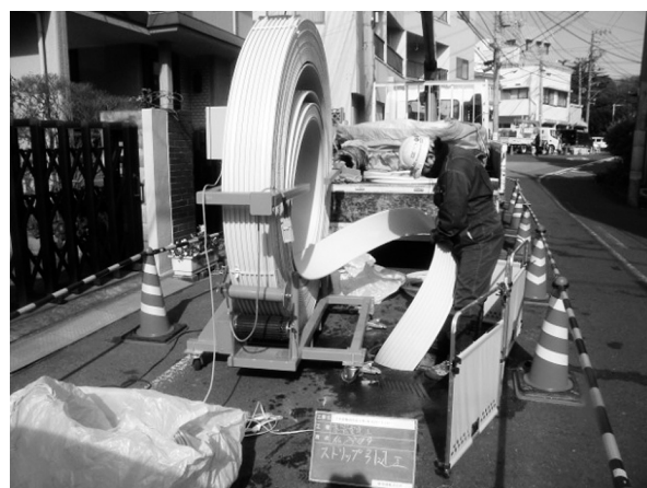
管更生状況（管外）
