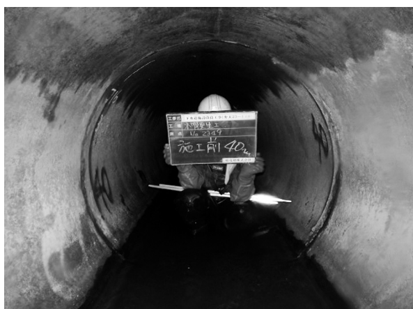
老朽管の状況（施工前）
