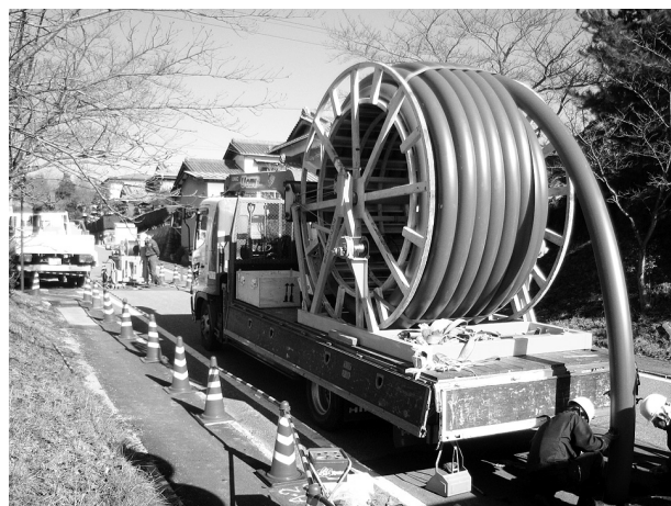
更生工事のようす
