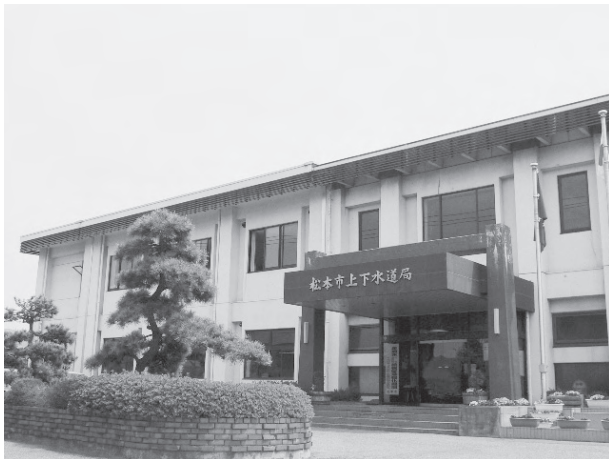
松本市上下水道局庁舎
