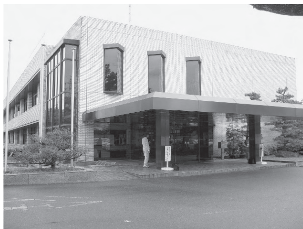
浜松市上下水道部庁舎
