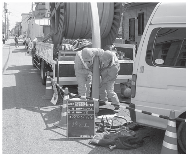
更生工法の施工現場
