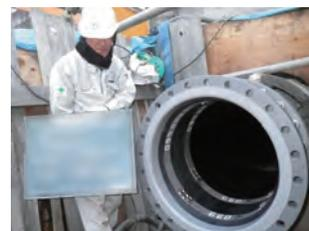
写真6 管端処理
