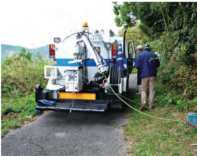
図3 高圧洗浄車による洗浄状況
